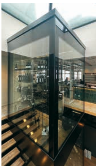
Vinski stolp so v proizvodni dvorani že vnaprej izdelali, na samem mestu ga je Maximilian Reiter in njegova ekipa sestavila ter postavila na noge.
