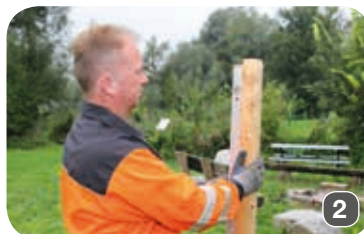
VSTAVITE DROG Nosite zaščitne rokavice.
