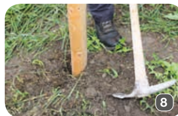
PREKRIJTE SMOLO Z zemljo, da maso zaščitite pred neposrednimi sončnimi žarki.
