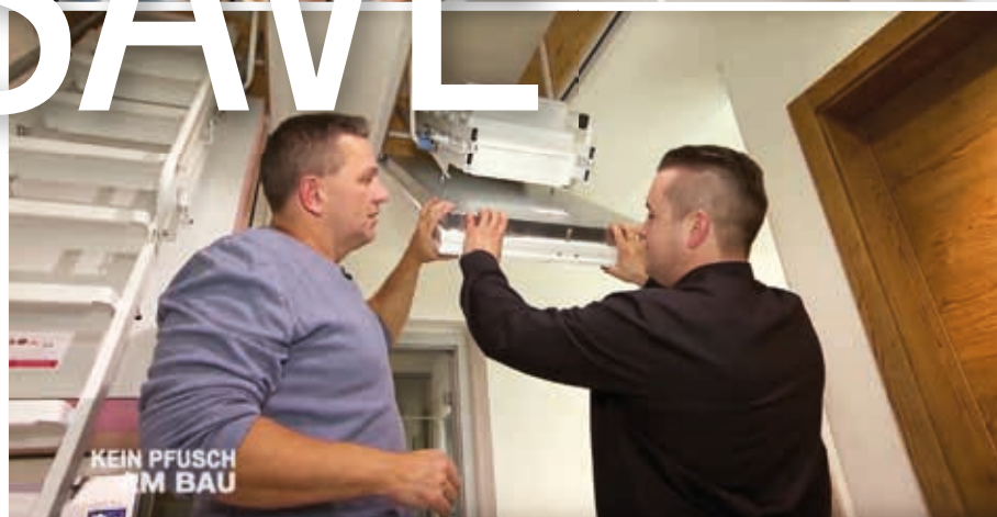
Günther Nussbaum, gradbeni izvedenec iz oddaje Kein Pfusch am Bau in Alexander Wipplinger, vodja prodaje v podjetju Wippro, preskušata že vgrajene podstrešne stopnice.
